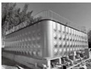
更新工事中の鳥居前配水池
