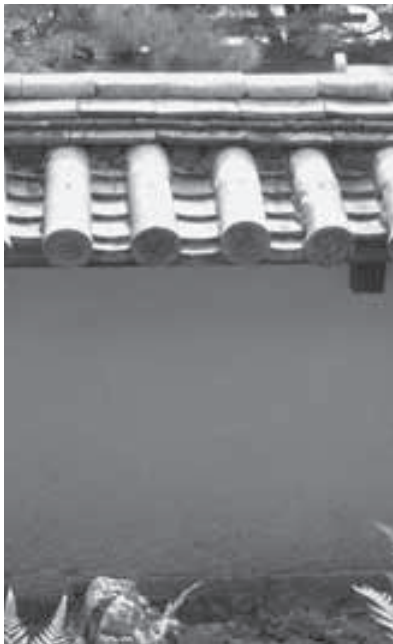
築地塀 (ついでい) 土を突き固め、上に屋根をかけた土塀のこと。 単に築地 (ついで) ともいう。現在は、御所 や寺院などで見ることができる。
